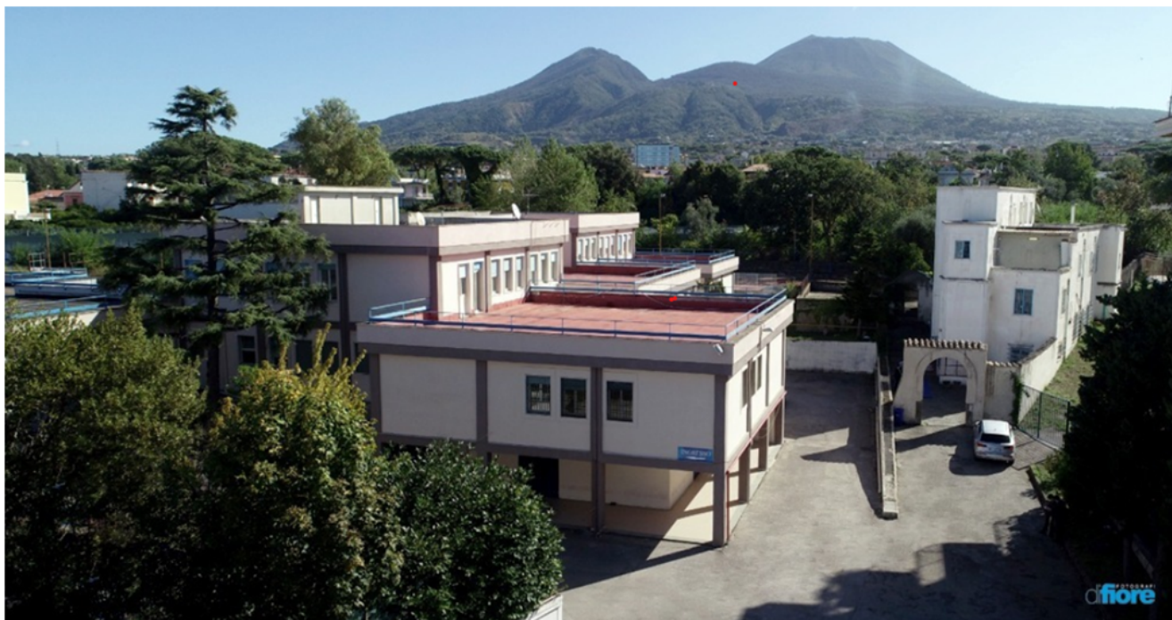
Sede Centrale Via De Nittis
